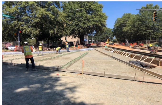
Five Points Intersection Before Pour
